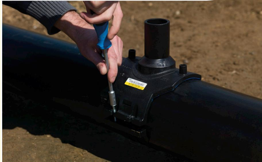
La abrazadera de derivación AGRU ha sido desarrollada para permitir la instalación sencilla de derivaciones en tuberías de PE. Fabricada en material PE 100-RC de alta calidad, la abrazadera de derivación garantiza una instalación sencilla y una fiabilidad total. Utilizando abrazaderas de derivación, la instalación de derivaciones es sencilla y económica.
