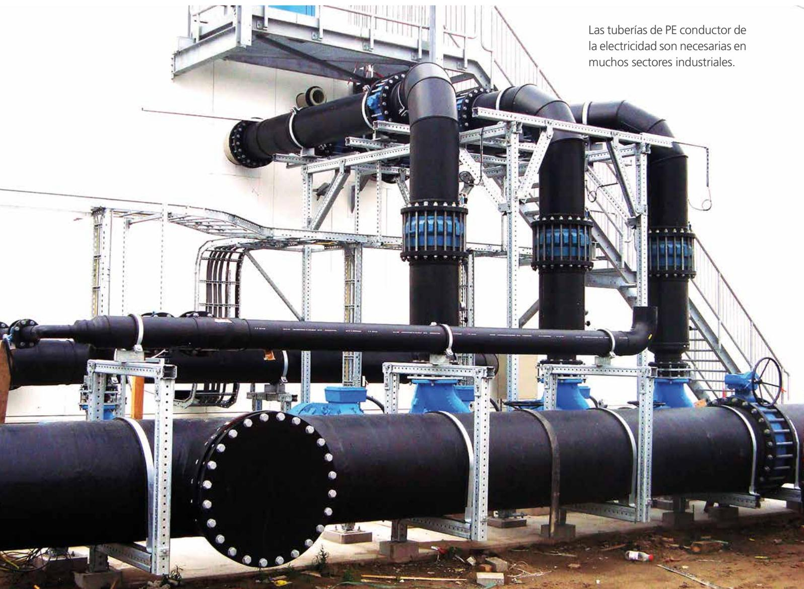
Las tuberías de PE conductor de la electricidad son necesarias en muchos sectores industriales.
