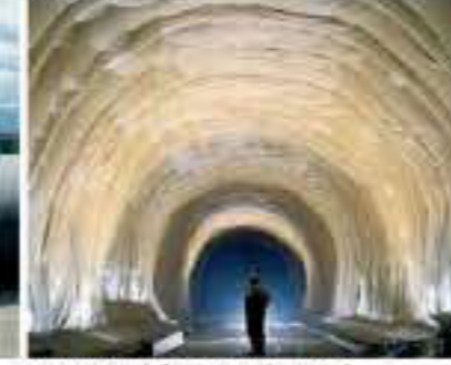
Impermeabilización de túnel
