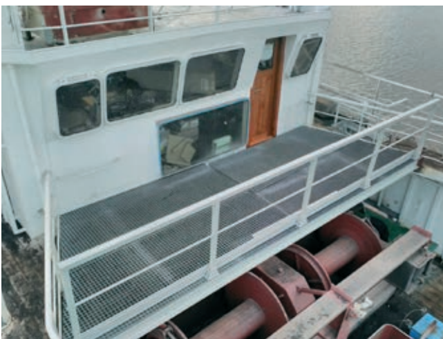
Construcción de estructuras ligeras y resistentes.
