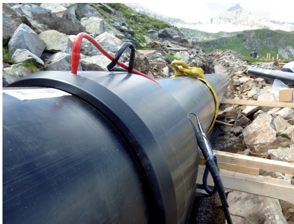
FIGURA 3. Los sistemas de tuberías Agruline PE 100-RC se pueden instalar sin lecho.
