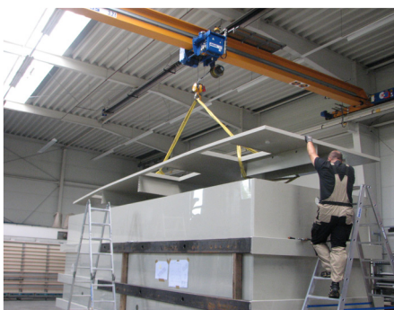
CUBIERTA DEL DEPURADOR DE AIRE
