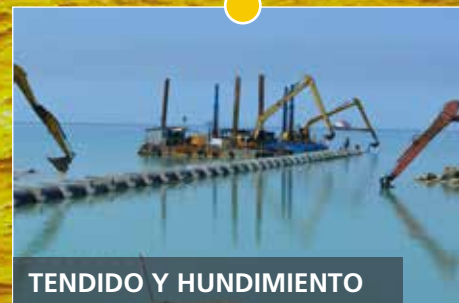
INSTALACIÓN TRAMOS FLOTANTES
