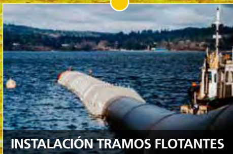
TENDIDO Y HUNDIMIENTO
